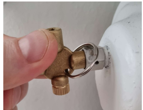
Figur 2 Rätt anslutning med avluftningsnyckeln
