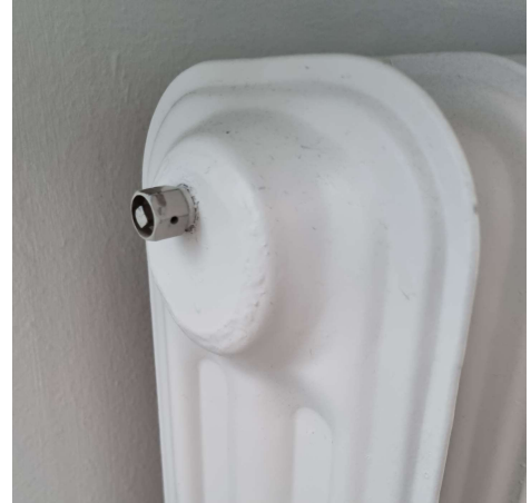
Figur 1 Lokalisering av avluftningsventil
