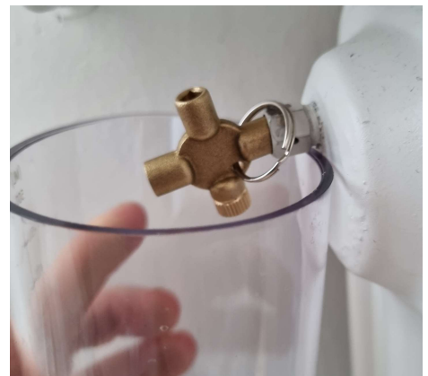
Figur 3 Placera ett kärl tätt under avluftningsventilen
